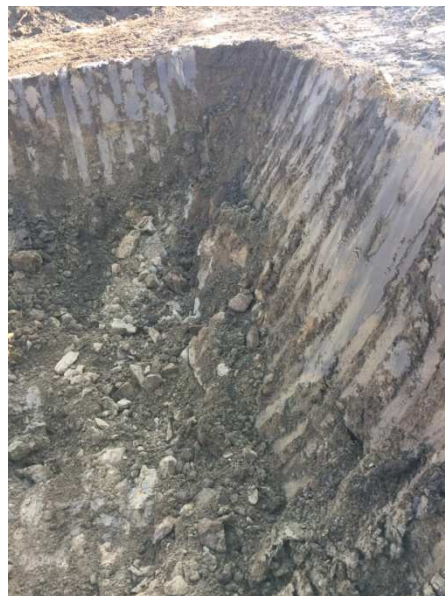
Scavo in area limitrofa, limi sabbiosi e substrato roccioso alla base dello scavo
